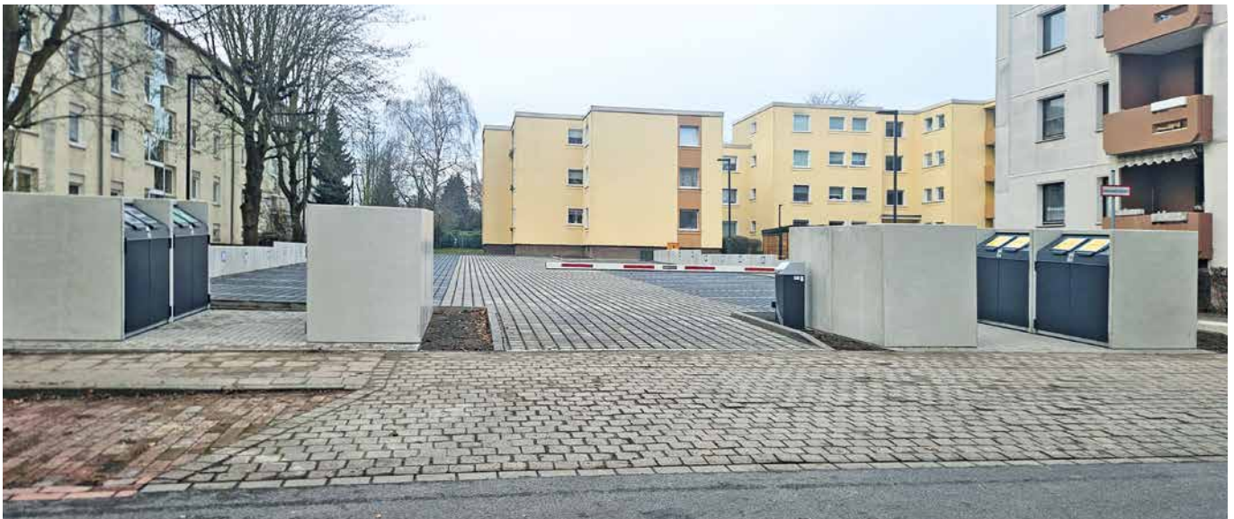
Neue Parkebene mit 31 Stellplätzen und zentralem Müllstandplatz
